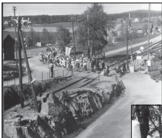
Over: 17. maitoget ved Skjæringa.
