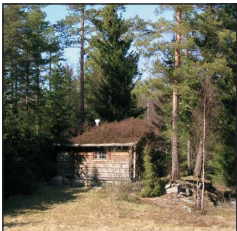
Det er satt opp både en liten hytte og et uthus i laftet tømmer på Køya, noe som har gitt den tidligere husmannsplassen nytt liv i idylliske omgivelser. Foto: Øistein Bø
