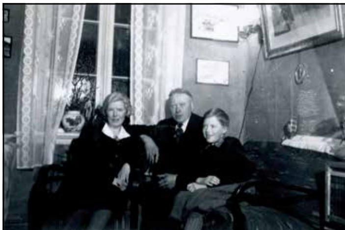
Forfatteren som guttunge sammen med sine foreldre, Edvard og Tordis Kullerud. Det var Edvard som midt på tjuetallet flyttet fra Kullerud for å søke jobb.
