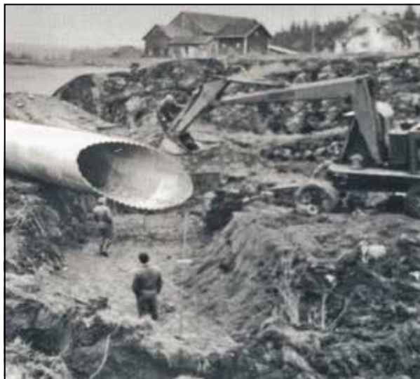
Legging av rør i bekken ved Skofteby. I bakgrunnen ses husene på Skofteby gnr 3036, bnr 9.
