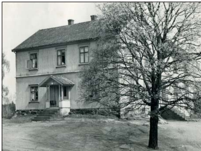
Foreningen Samhold fikk i 1959 kjøpe Kokkimskolen for 20.000 kroner. Dette bildet er tatt tidligere på 1950-tallet, mens bygget enda var skole for Ovaskogs. Foto: Thor Fjeld. Bildets eier: Varteig Historielag.
