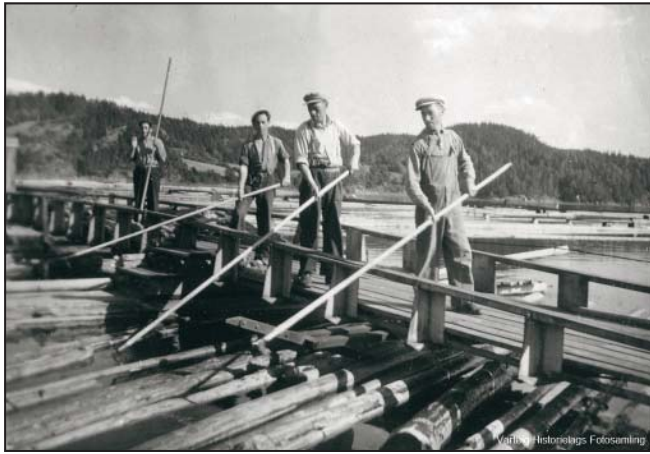
Fløtingen i Glomma ga verdifull sysselsetting. Her er fire brødre fra Grytedalen i arbeid på brua over renna ved Glennetangen lense. Fra venstre ser vi Håkon, Peder, Johannes og Einar. Foto: Ukjent. Eier: VHS FOTOSAMLING.
